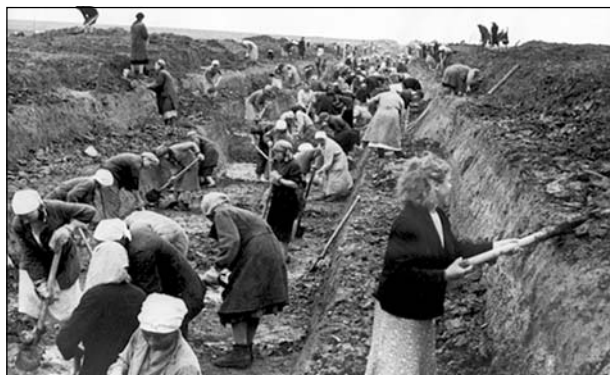
Строительство оборонительных сооружений
